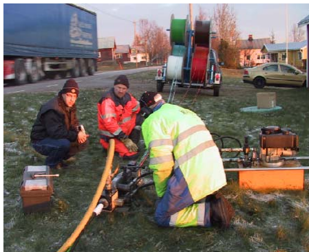
Figuur 14. Het aanleggen van glasvezel 54
